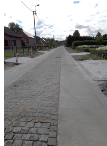
Figuur 9: De Kleistraat, een erftoegangsweg binnen een mobiliteitskamer, werd recent als karrenspoor heringericht.
