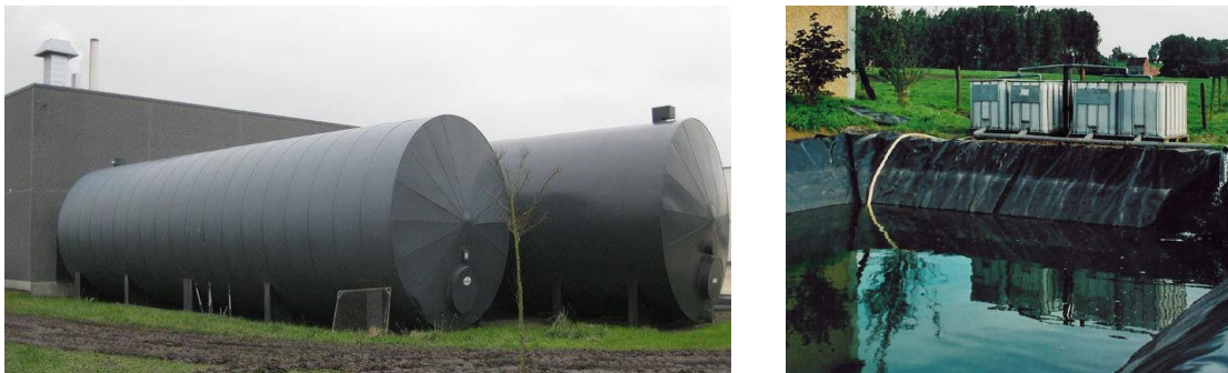
Figuur 50. Buffertanks en foliebekken voor de opslag van regenwater (Bron: Departement Landbouw en Visserij; en Provincie Oost-Vlaanderen).
